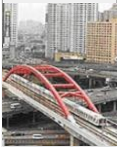
高架轻轨明珠线 Overhead light metro
