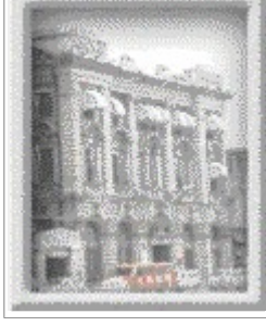
东方大楼 Oriental building
